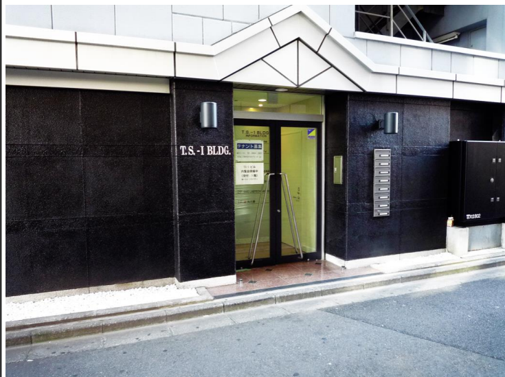
玄関・エントランス
