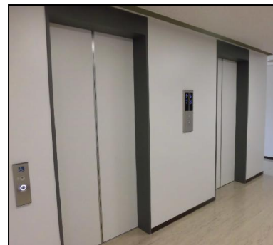
各階エレベータホール
