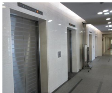
エレベーターホール
