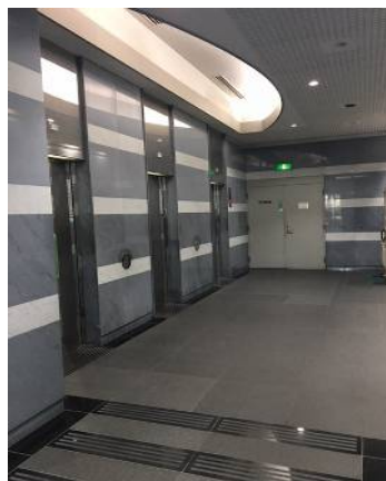
エレベーターホール
