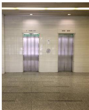
エレベーターホール
